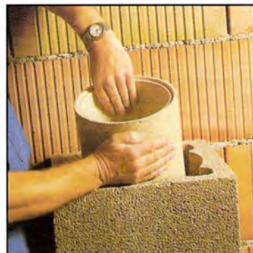
5) A samottcsövek behelyezése
