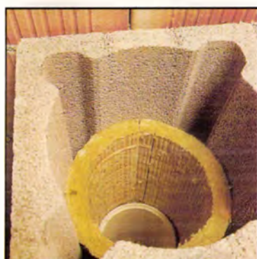
3) A szigetelőlapok elhelyezése
