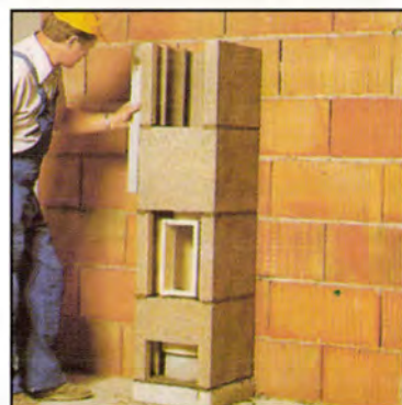
6) A tisztítóajtó és füstcső-csatlakozók beépítése
