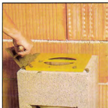
2) A habarcsot a habarcssablon alkalmazásával hordjuk fel
