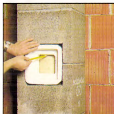
7) A cserépkályha csatlakozó beépítése
